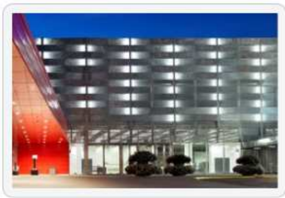
Messe Stockholm mit "gewebter", feuerverzinkter Blechfassade
